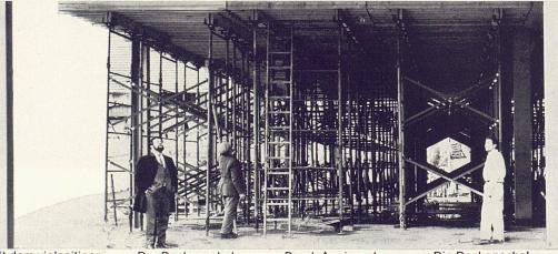
Mit dem vielseitigen Deckenschalwagen MILLS können Sie Deckenspriessungen mit mehreren Einsätzen einfach und schnell ausführen. Der Deckenschalwagen besteht aus Schaltischrahmen, Diagonalkreuzen, Rahmenfüssen und Auszugsstücken. Die Montage der Dekkenschalwagen ist denkbar einfach. Die Rahmen werden gegenseitig mit Diagonalkreuzen verstrebt und automatisch verriegelt, Längsbalken in die Zweiweg-Gabeln gelegt und darauf die Schalung montiert. Werkzeuge sind für die Montage nicht erforderlich.
