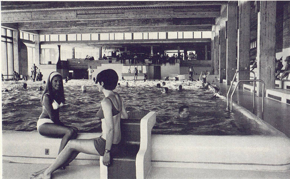
Objekt: Neubau Hallenbad St. Moritz Projekt und Bauleitung: Architektengemeinschaft R. Obrist + A. Theus, St. Moritz
