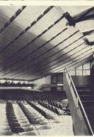
Konzertsaal Schrägwand, Vertikalschnitt Elemente aus NOVOPAN 40 mm, furniert und NOVOPAN Hängedecke
