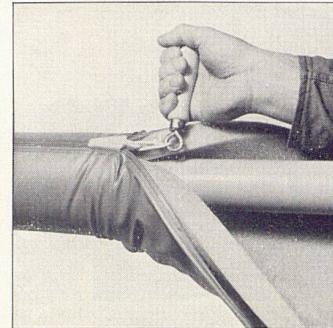
die Rohrisolierung mit Gleitverschluß,
