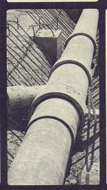
Kanalisationsrohre für Schmutzwasserleitungen sind weitere Produkte aus dem Werkstoff Asbestzement «ETERNIT». Zur Be- und Entlüftung von Gebäuden werden dem Fachmann Kanäle und Rohre, für den Kabelschutz Kabelträger, Kabelrohre und Zores zur Verfügung gestellt.
