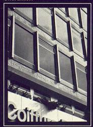
E. Hauer's Erben, Zürich Geschäftshaus mit vollisolierten ALSEC-50-Fenster, Isolierplatten-Brüstungen mit vorgehängten Silafont-Gussplatten.
