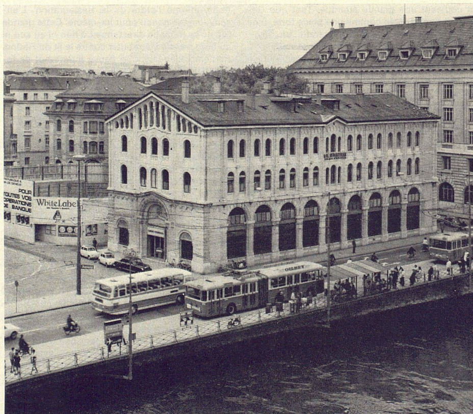
1 Vue générale de l'immeuble
