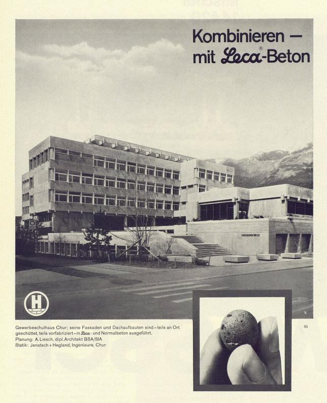
Fassaden aus &cc -Sichtbeton bieten keine besonderen Probleme. Selbst kompliziertere Bauteile lassen sich ohne weiteres herstellen – sei es in Ortsbeton, sei es als vorfabriziertes Element.
