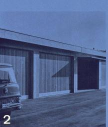
1 Falt-Flügeltor mit Brüstung in Stahlblech und fest verglastem Oberteil
