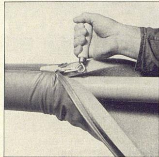
die Rohrisolierung mit Gleitverschluß,
