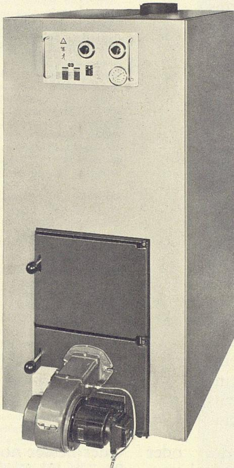
ACCUMAT-Realtherm, ein neuartiger Heizkessel, kombiniert mit einem leistungsfähigen Boiler, auch ausrüstbar für die Verfeuerung von festen Brennstoffen. Günstige Abmessungen, einfache Montage, beste Wirtschaftlichkeit, minimale Wartung, hoher Komfort und: ein vorteilhafter Preis.
