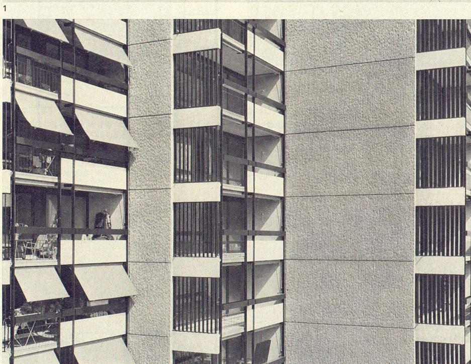
1 Die Wohneinheit wurde sägeförmig gegeneinander verschoben, so daß die 27 vertikalen Einheiten zu drei Blöcken zusammengesetzt werden konnten
