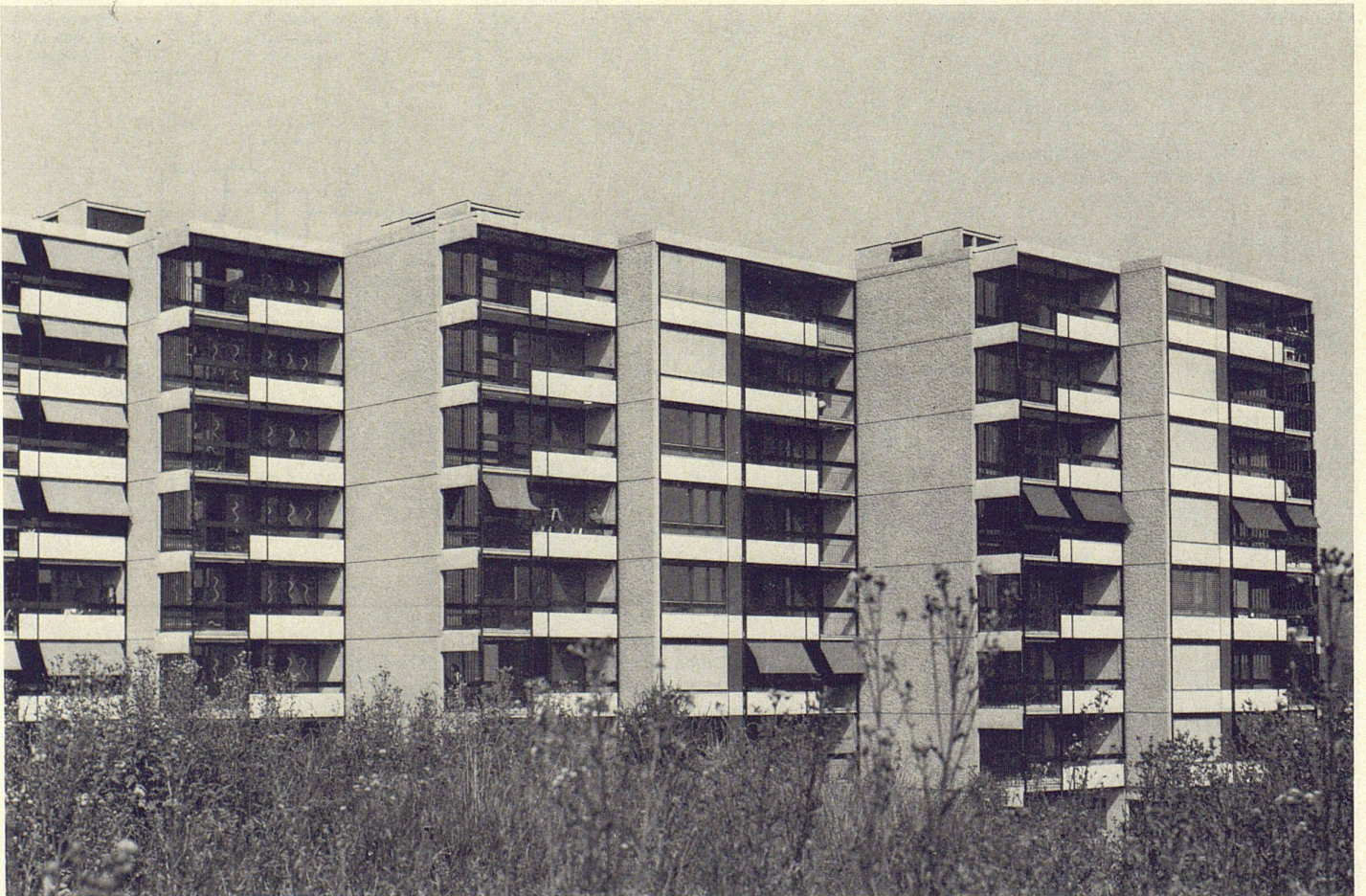
9, 10 Die Vorfabrikation kam mit insgesamt 54 Platten- typen aus; die Maße aller Teile sind gemäß der Modulordnung koordiniert 11 Südwestfassade
