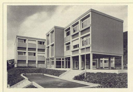
Das Variel-Bausystem ermöglicht die Vorfabrikation von ein- und mehrgeschossigen Schulen. Variel-Raumelemente sind standardisierte Raumteile in solider Betonkonstruktion. Variel bietet sehr preisgünstige, kurzfristige Lieferungen.
