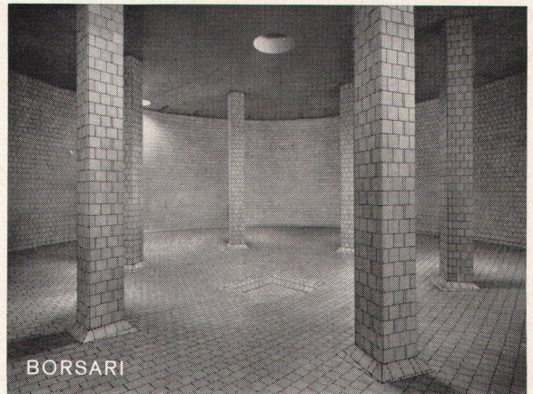
Flughafen-Immobilien-Gesellschaft Zürich-Kloten 7 Tanks total 5600 m 3 Schweröl
