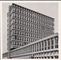
Architekt: Ernest Martin, Genève; Leichtmetallfassade und -fenster: METALLBAU HIRSCH, Biel; Konstrukteur: IGECO S.A., Etoy VD Das ist der neue Güterbahnhof mit Bürohaus von La Praille. Der Bau ist aus vorgegossenem Beton und Glas und hat 665 Fenster. Vorgeformte Profile erwiesen sich als zweckmässigstes und wirkungsvollstes Mittel zur Abdichtung und Verglasung der Bauelemente — weil sie zuverlässiger und leichter zu installieren sind und keiner Wartung bedürfen.
