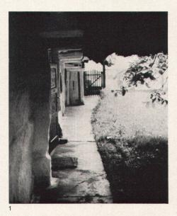
1, 2 Von den Vorfahren Iernen heißt, dem Menschen, Verwendungszweck, Material und Vermögen entsprechend bauen. Ein Beispiel von gestern und heute richtig erfaßt und von zeitloser Gültigkeit. Oben: Blockbauweise, außen gekalkt, 18. Jahrhundert; unten: Fertigteilbauweise, Architekt: Rainer Senn
