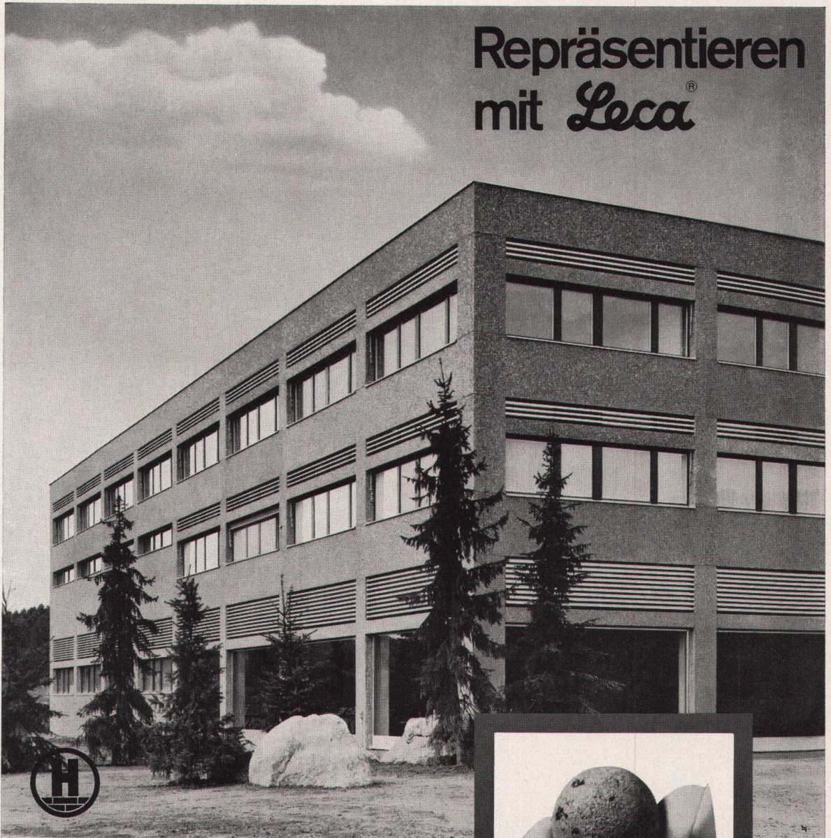
Leca -Fassadenelemente mit Waschbeton-Vorsatz am Betriebs- und Bürogebäude der O. Richei AG, Dättwil Planung: Obrist + Martin, Architekten, Baden und St. Moritz Bauausführung: Rud. Stüssi AG, Bauunternehmung, Dällikon
