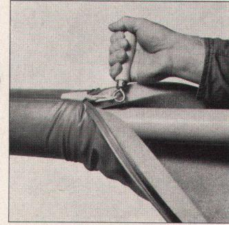
die Rohrisolierung mit Gleitverschluß,
