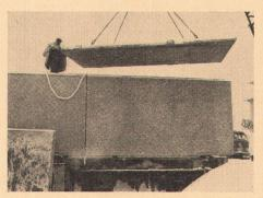
nenausbauteile an der Baustelle reibungslos eingebaut werden können. Sehr oft aber wird der Innenausbauteil schon in der Fabrik in das Rohbauelement eingebaut und wird dadurch zum kompletten Bauelement, welches noch höhere Anforderungen an die Lagerung und Montage stellt. Ein Bauelement spiegelt an sich den ganzen Bauprozeß wider.
