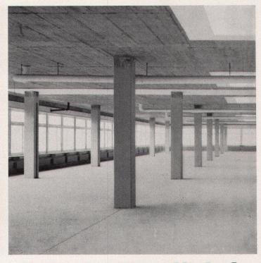
druckfest, robust dichte, geschlossene Oberfläche mineralöl- und lösungsmittelbeständig staubfrei, benötigt keine Pflege
