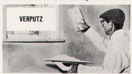
Styrofoam lässt sich ausgezeichnet mit allen gebräuchlichen Materialien verputzen. Pressplatten, Gipstafeln und Täfelungen können direkt aufgetragen werden. Styrofoam wird mit Zementmörtel unmittelbar auf das Mauerwerk aufgeklebt. Dadurch senkt es Arbeitszeit und Arbeitskosten erheblich.
