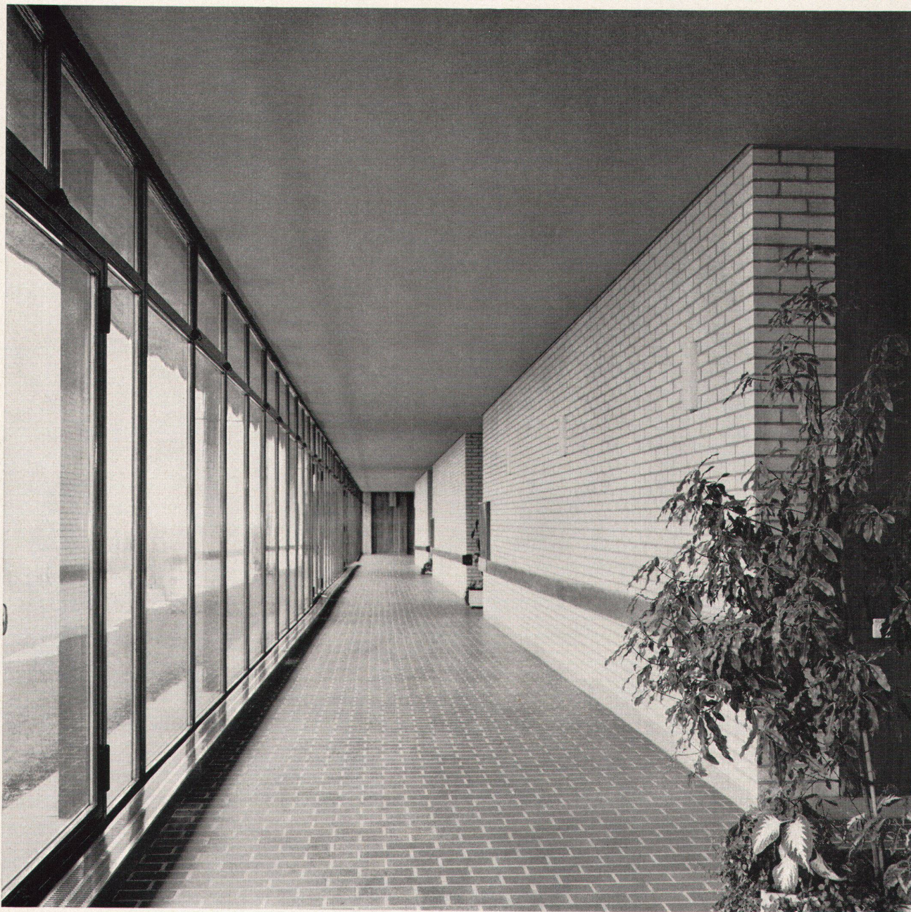
Glatte, heruntergehängte Decke aus Gitro-Platten
