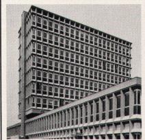
Architekt: Ernest Martin, Genève; Leichtmetallfassade und -fenster: METALLBAU HIRSCH, Biel; Konstrukteur: IGECO S.A., Etoy VD Das ist der neue Güterbahnhof mit Bürohaus von La Praille. Der Bau ist aus vorgegossenem Beton und Glas und hat 665 Fenster. Vorgeformte Profile erwiesen sich als zweckmässigstes und wirkungsvollstes Mittel zur Abdichtung und Verglasung der Bauelemente — weil sie zuverlässiger und leichter zu installieren sind und keiner Wartung bedürfen.
