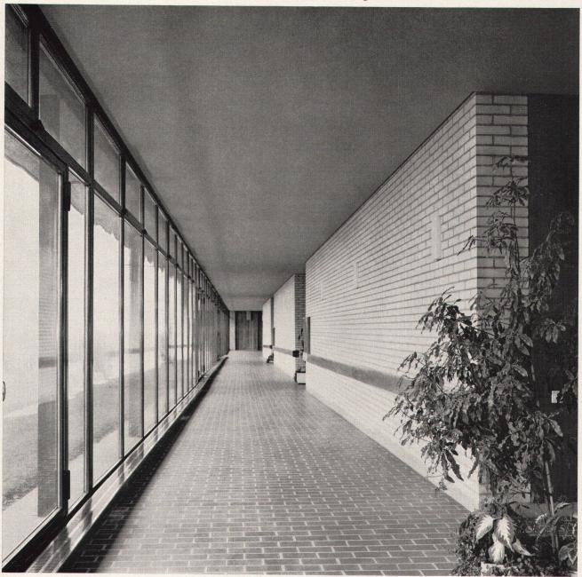
heruntergehängte Decke aus Gitro-Platten
