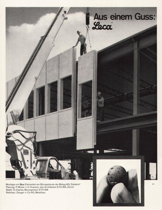
Man kann ein Aussenwand-Element so aufbauen: Ein Kern, der den statischen Ansprüchen genügt. Eine Schicht, die isoliert. Eine Schicht als Wetterhaut und zur Zierde. Vielleicht noch eine feuerhemmende Schicht…
