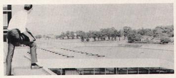
**Schweiz – Flughafen Genf** Verhinderung von Wärmedehnung: 10 000 m² Roofmate wurden im neuen Flughafengebäude Genf verlegt, weil es die bei Wärmedehnung auftretenden Spannungen in der Dachterrasse verhindert.
