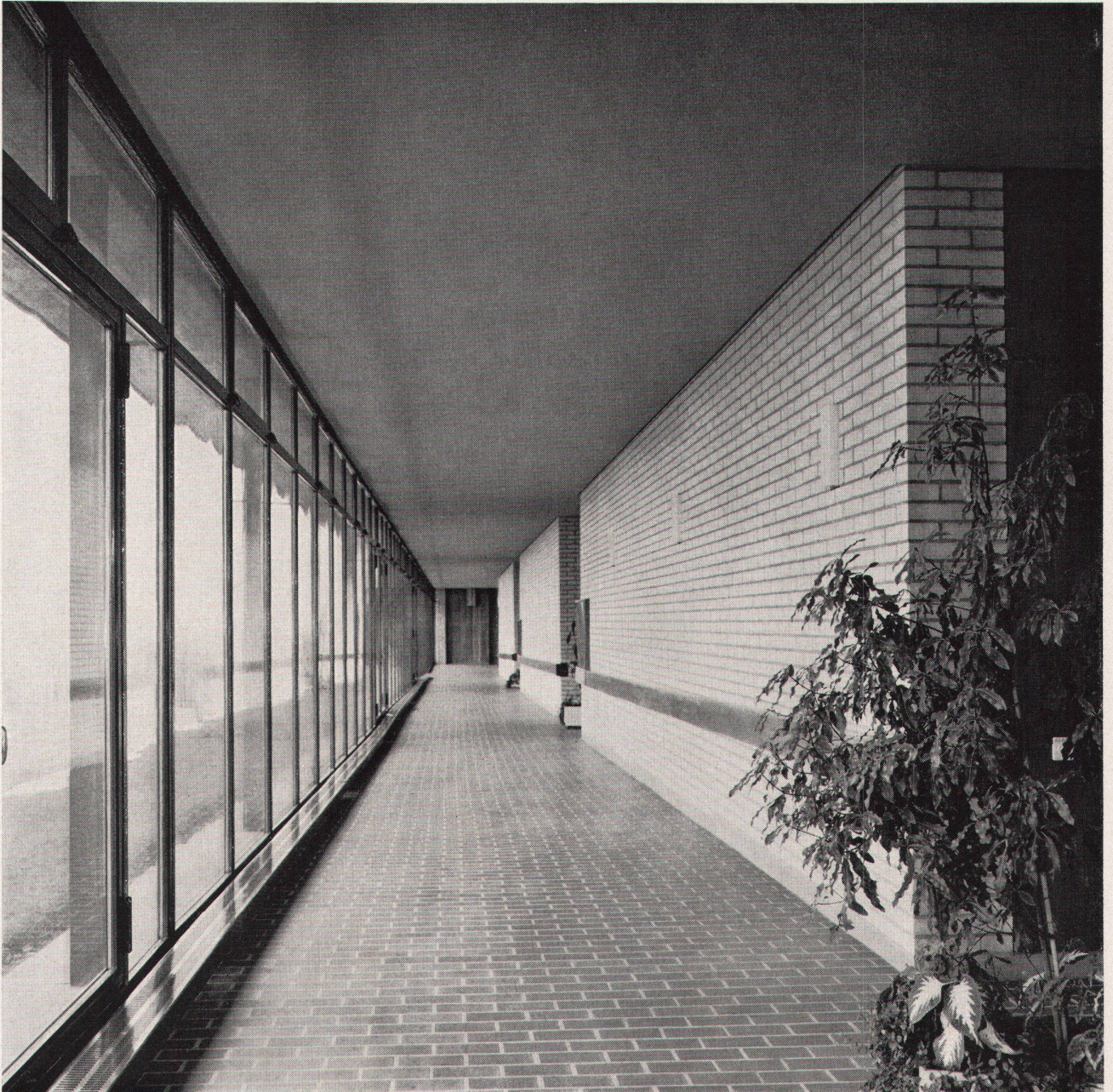
Glatte, heruntergehängte Decke aus Gitro-Platten
