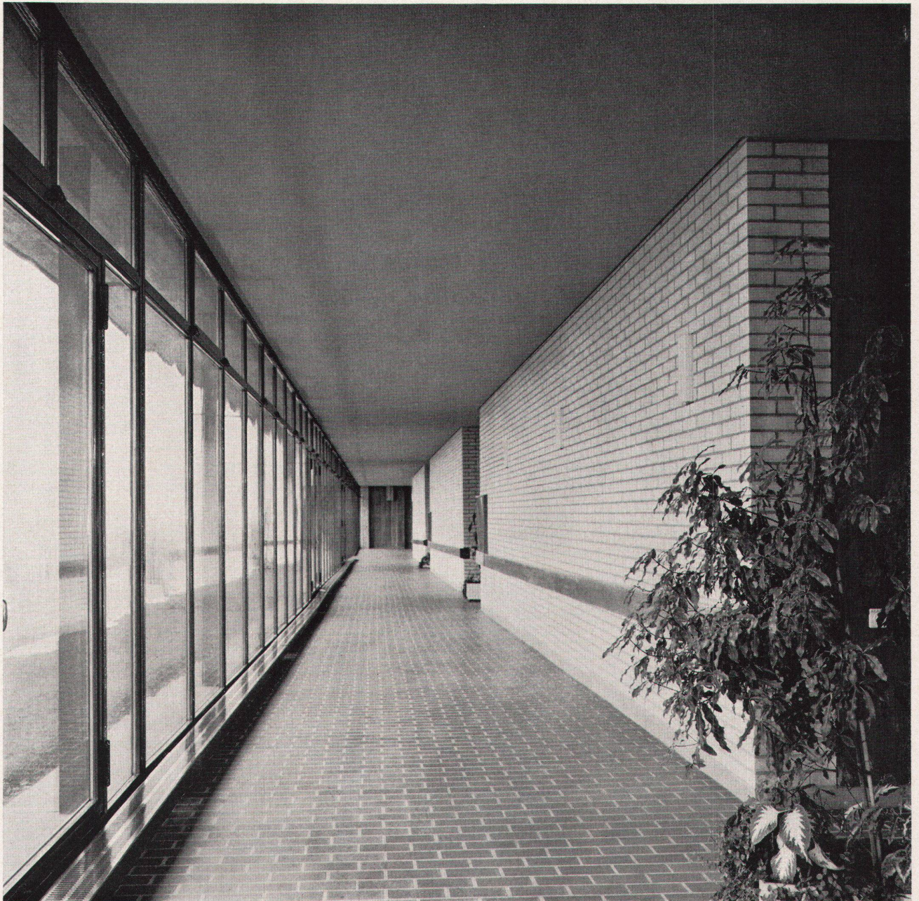
Glatte, heruntergehängte Decke aus Gitro-Platten
