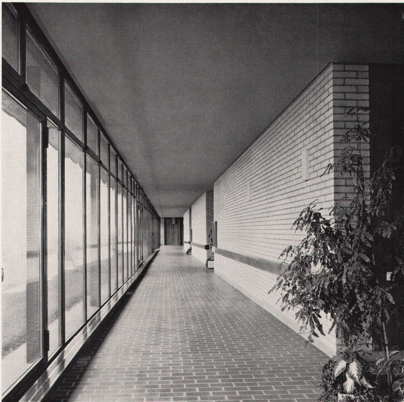
Glatte, heruntergehängte Decke aus Gitro-Platten
