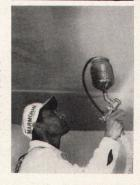
masse lasst sich sehr einfach und praktisch verarbeiten: Entweder wird sie mit einer Traufel mühelos aufgezogen oder sie wird rationell und sauber mit einer Spritzpistole aufgespritzt. Ansatzstellen gibt es keine! MARMORAN Innenputz ist schon nach 12 Stunden gebrauchstrocken: Stunden gebrauchstrocken;
