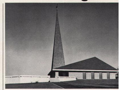
wendet. Eine wichtige Eigenschaft, die mit zur Verwendung von 4 cm starken Baumatten in der Dachkonstruktion aus Stahl und Holz beitrug, ist die Unbrennbarkeit.
