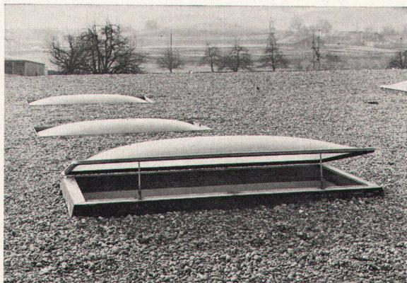
Hinten: Form A zum direkten Einbau in die Dachhaut
