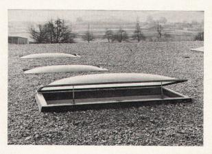
Hinten: Form A zum direkten Einbau in die Dachhaut
