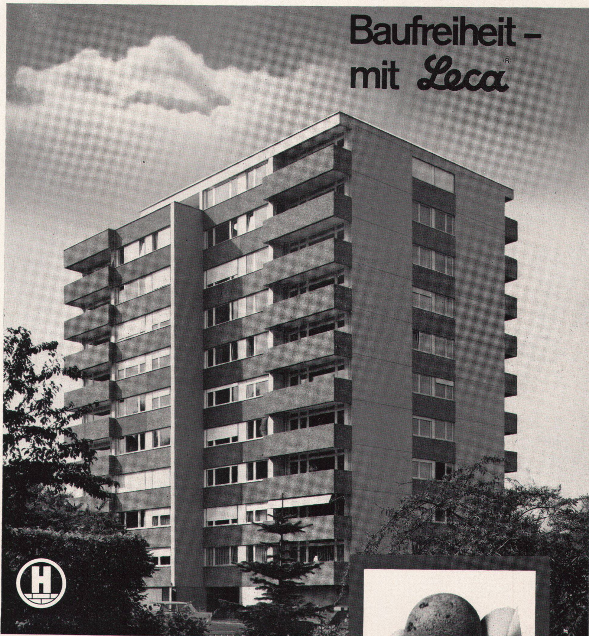
Wohnhochhaus «Regina» in Kreuzlingen Planung: G. Felber, Architekt, Kreuzlingen Statik: Zähler + Wenk, Ingenieure SIA, Kreuzlingen Bauausführung: A. Seger, Hoch- und Tiefbau, Kreuzlingen
