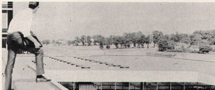
Schweiz – Flughafen Genf Verhinderung von Wärmedehnung: 10 000 m 2 Roofmate wurden im neuen Flughafengebäude Genf verlegt, weil es die bei Wärmedehnung auftretenden Spannungen in der Dachterrasse verhindert.
