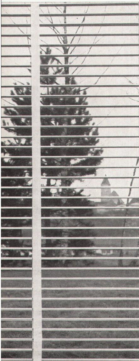
Typ 50, flexible Lamellen, enge Rasterbildung mit Senkrechttbetonung durch die breiten Stegbänder.
