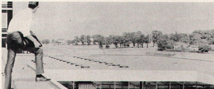
**Schweiz – Flughafen Genf** Verhinderung von Wärmedehnung: 10 000 m<sup>2</sup> Roofmate wurden im neuen Flughafengebäude Genf verlegt, weil es die bei Wärmedehnung auftretenden Spannungen in der Dachterrasse verhindert.
