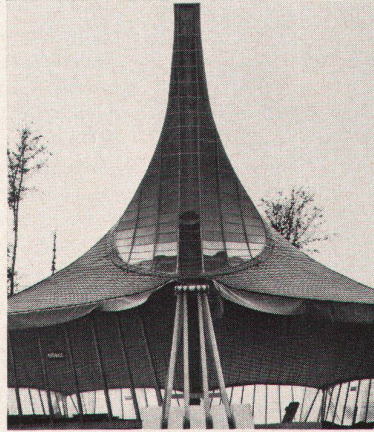
1-5 Das Modell des deutschen Pavillons für die Expo 67 in Montreal steht in Stuttgart und wird von Frei Otto für seine Kurse an der TU benützt
