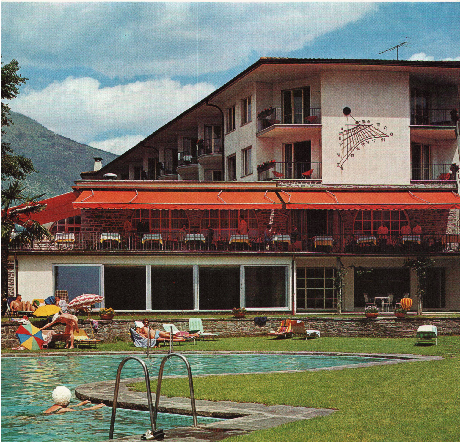
Beispiel eines nachträglichen Einbaues elektrisch bedienbarer Sonnenstoren an einem bestehenden Gebäude.
