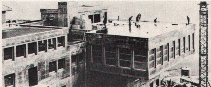
Schweiz – Bergstation Corviglia 2500 m.ü.M. Rauhes Klima: Roofmate wurde zur Dachisolation in der Bergstation Corviglia verwendet. Hier war wesentlich, dass Material verwendet wurde, das den schlimmsten Wetterverhältnissen widersteht.
