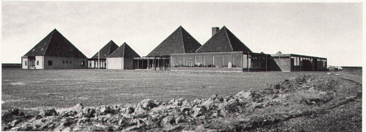
3 Ansicht von Süden, links der liturgische Raum, Mitte Aufenthaltsraum, rechts Speisesaal Vue côté sud: à gauche, la salle de recueillement; au centre, la salle de séjour; à droite, la salle à manger View from the south. Left, the liturgical room; centre, the lounge; right, the dining-room
