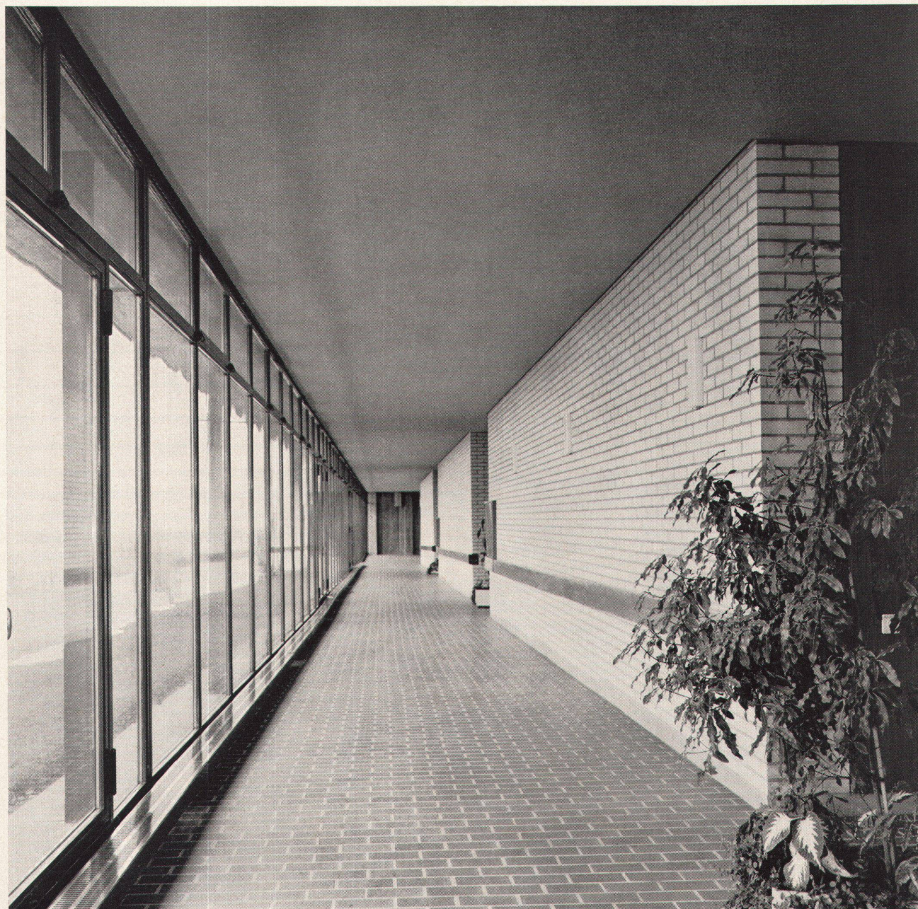
Glatte, heruntergehängte Decke aus Gitro-Platten
