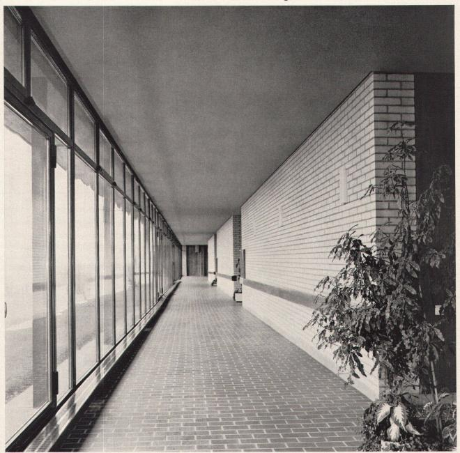
latte, heruntergehängte Decke aus Gitro-Platten
