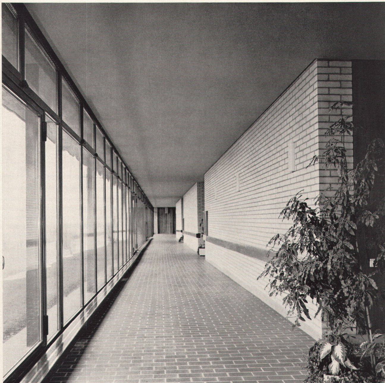
Glatte, heruntergehängte Decke aus Gitro-Platten
