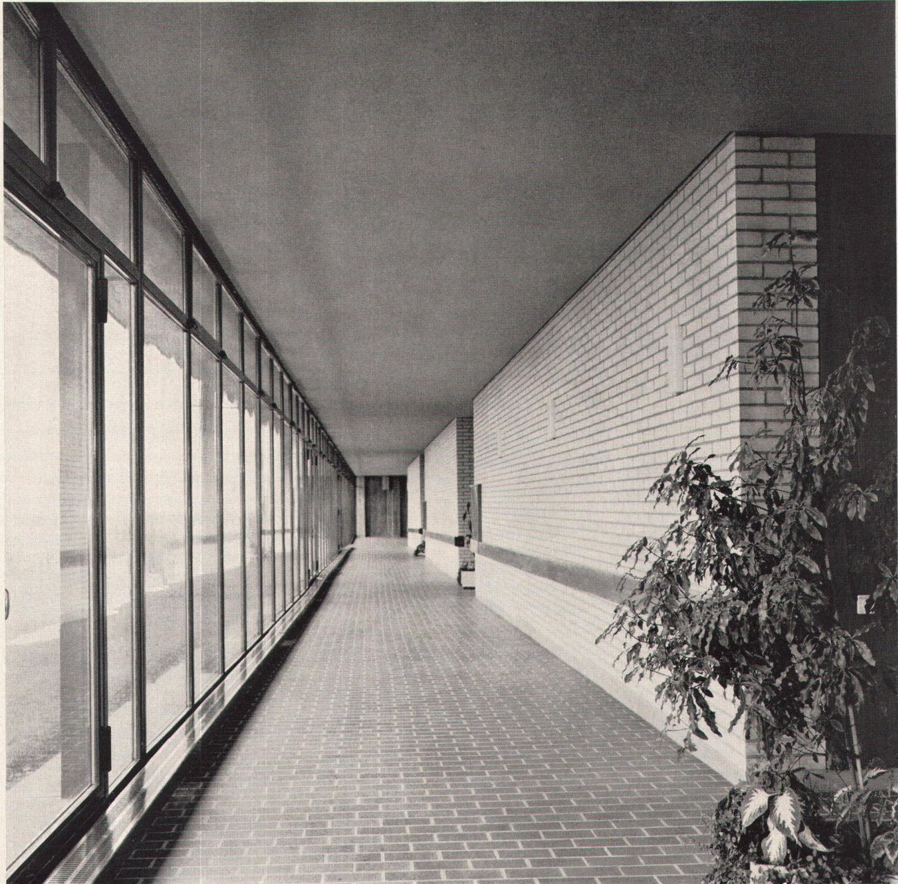
Glatte, heruntergehängte Decke aus Gitro-Platten
