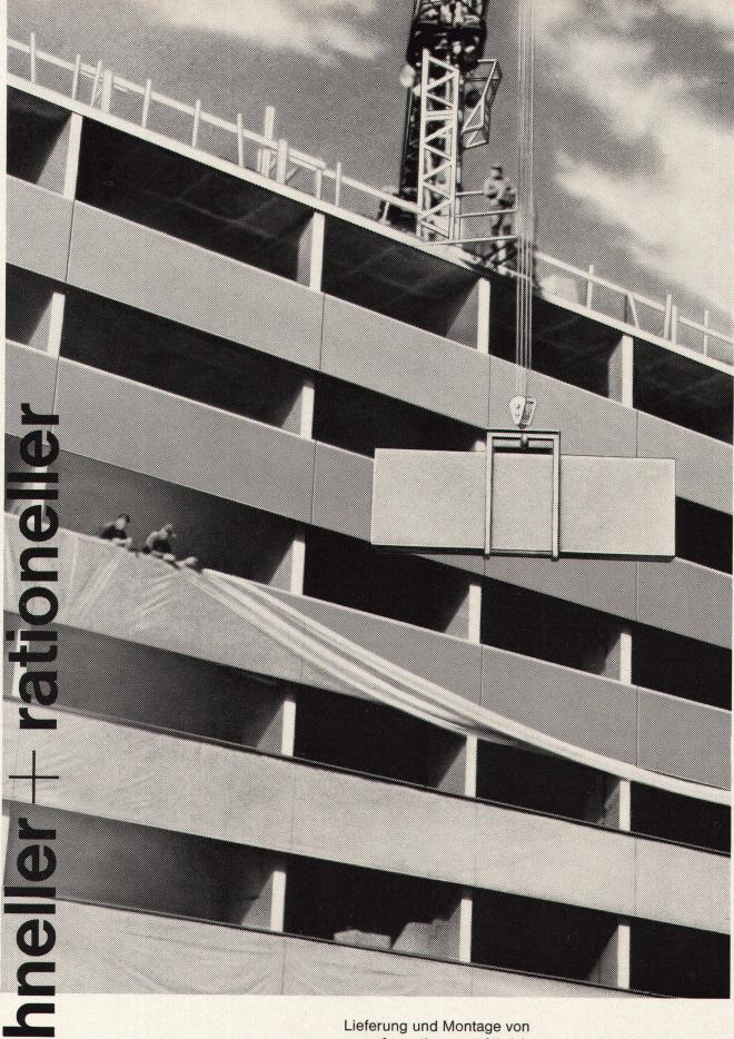
Lieferung und Montage von grossformatigen, vorfabrizierten Wand-, Dach- und Decken-Elementen in verschiedenen Systemen.
