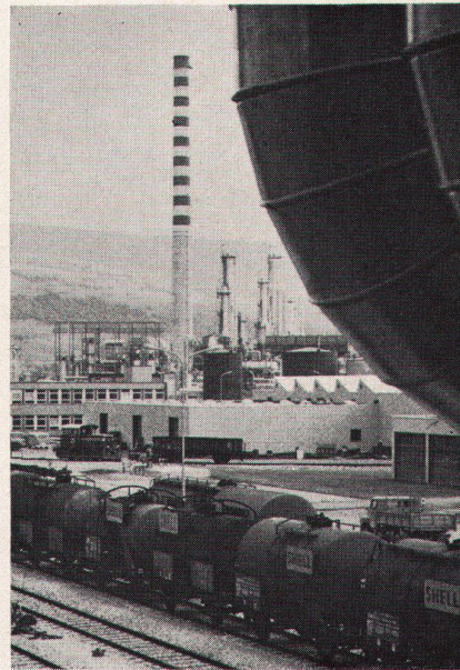
Raffinerie de Cressier SA • Gesamte Starkstrominstallationen in den Bauten
