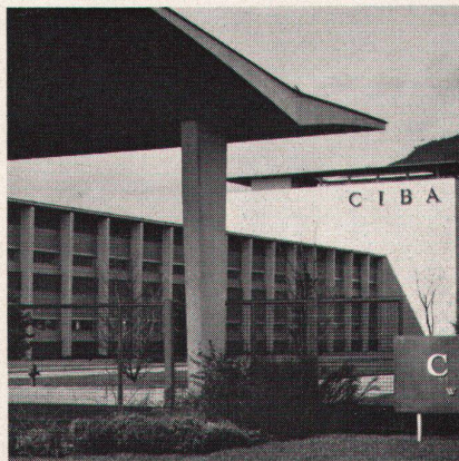
CIBA AG, Werk Stein • Telefonanlage • drahtlose Personensuchanlage HASLER • Bürolichttruf • Uhrenanlage • Signalanlage • manueller Feueralarm/Projektierung und Installation
