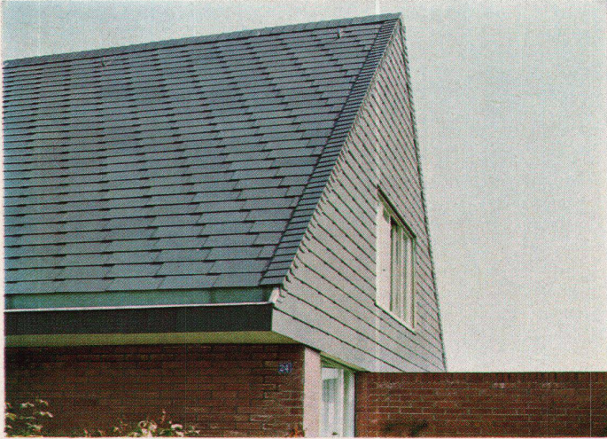
Wohnhaus bei Zürich mit Dacheindeckung und Giebelverkleidung mit schwarzen Asbestzement-Schiefern.
