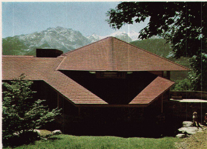
Ferienhaus im Berner Oberland — Dach aus braunen Asbestzement-Schiefern in Doppeldeckung und mit Strakkord-Grat.
