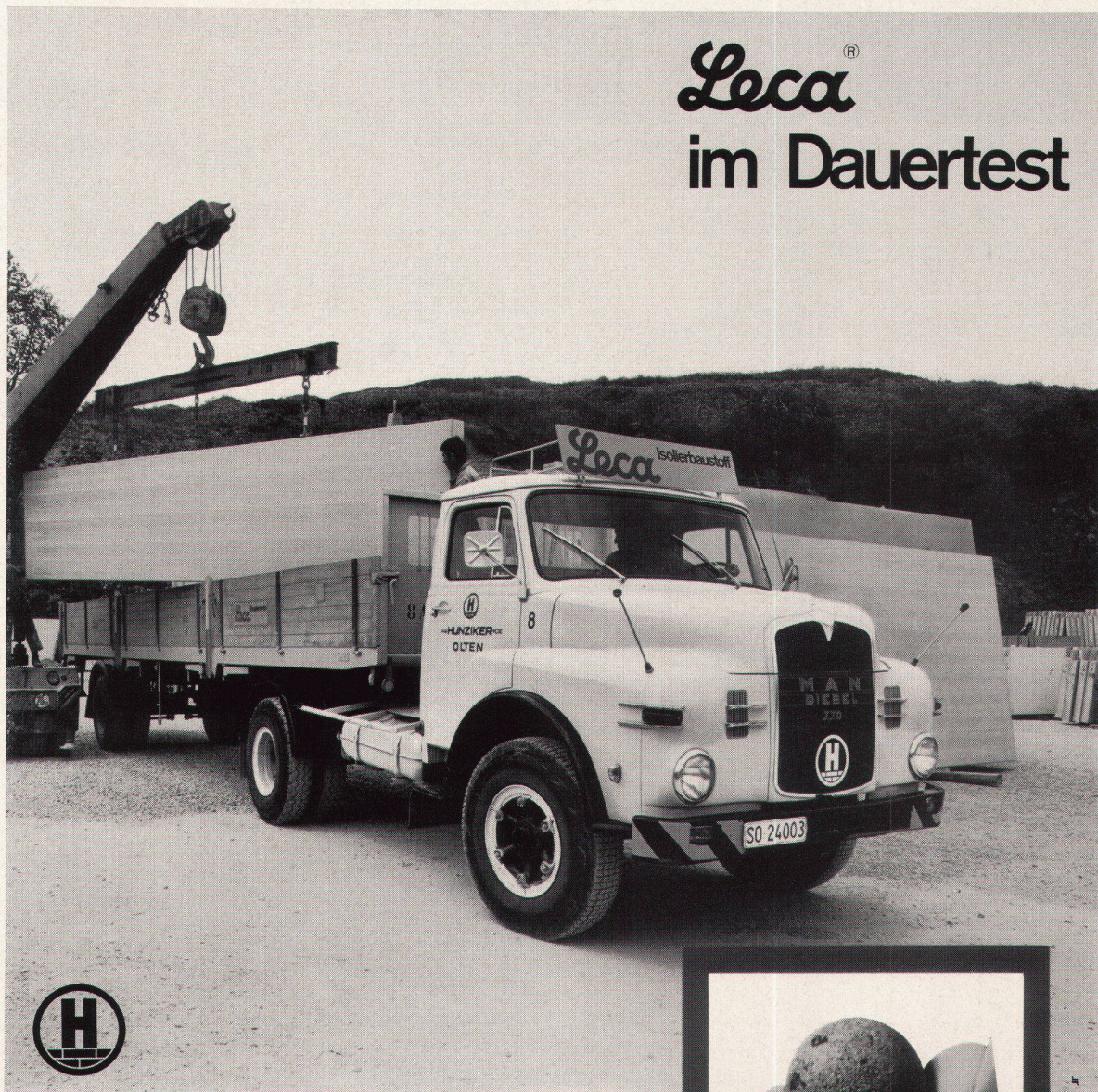
Verlad eines grossformatigen, vorfabrizierten Leca -Elementes auf einen Spezial-Sattelschlepper im Werk Olten.
