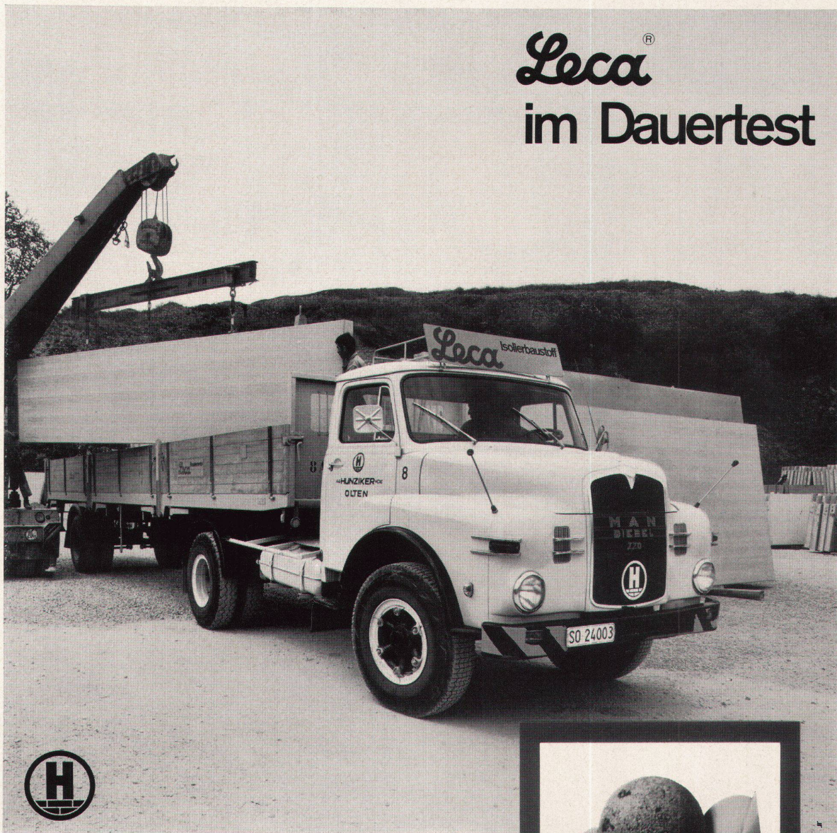
Verlad eines grossformatigen, vorfabrizierten Leca -Elementes auf einen Spezial-Sattelschlepper im Werk Olten.
