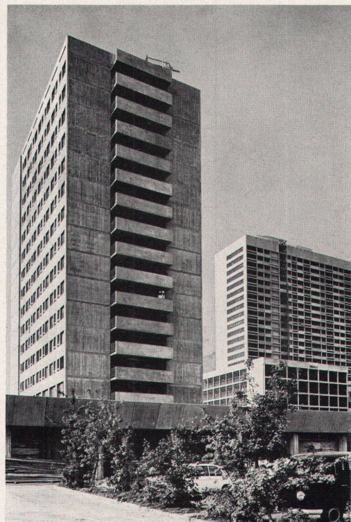
Stadtspital Triemli, Zürich, Personalhaus
