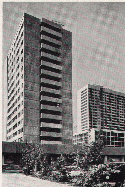
Stadtspital Triemli, Zürich, Personalhaus
