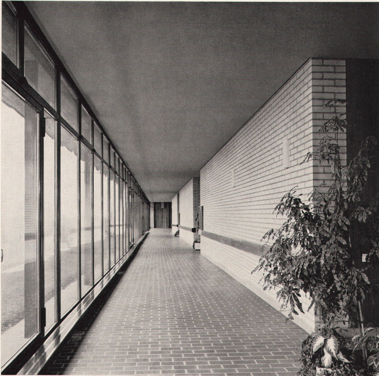
Glatte, heruntergehängte Decke aus Gitro-Platten
