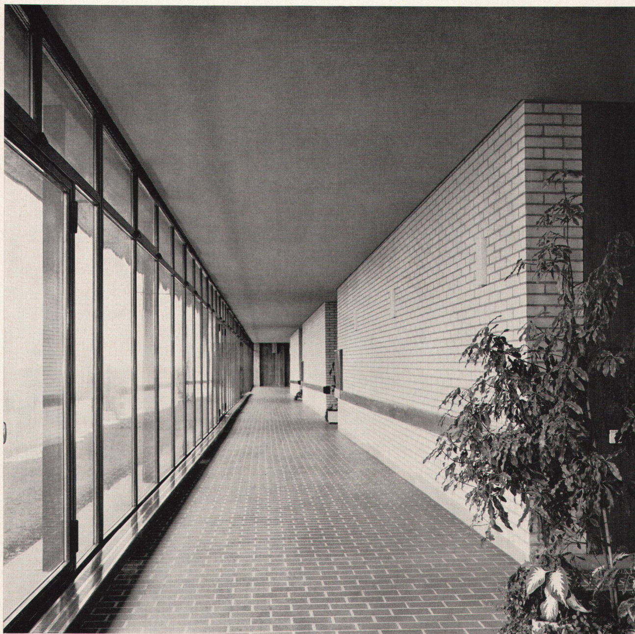
Glatte, heruntergehängte Decke aus Gitro-Platten
