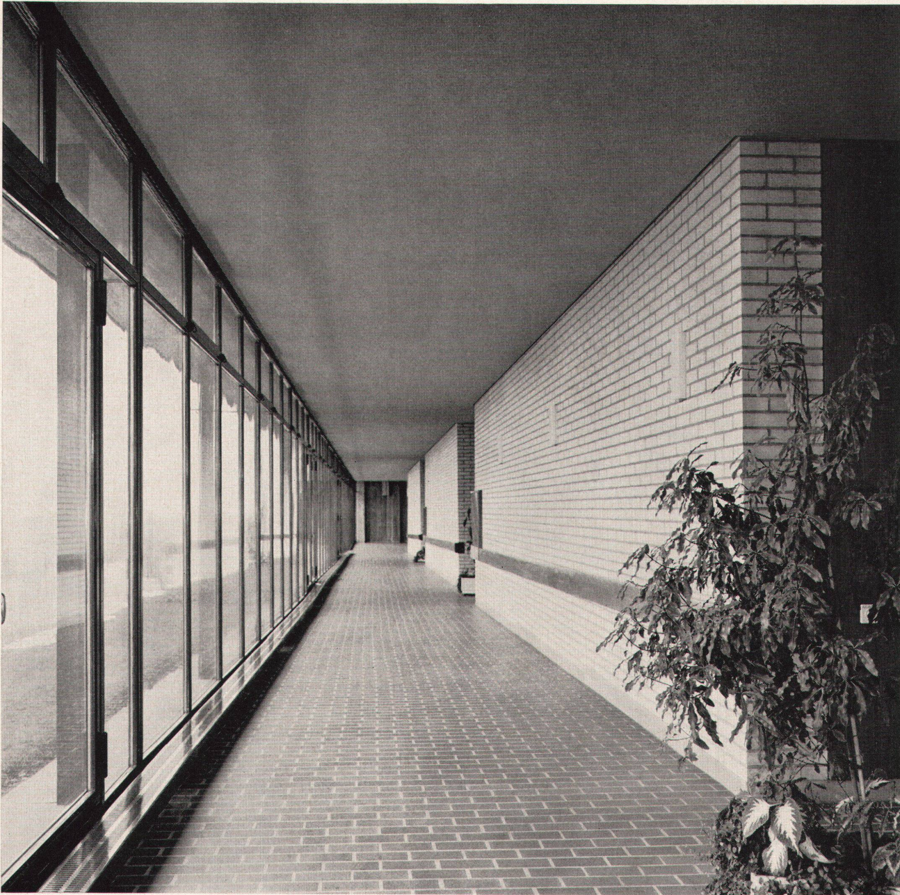
Glatte, heruntergehängte Decke aus Gitro-Platten
