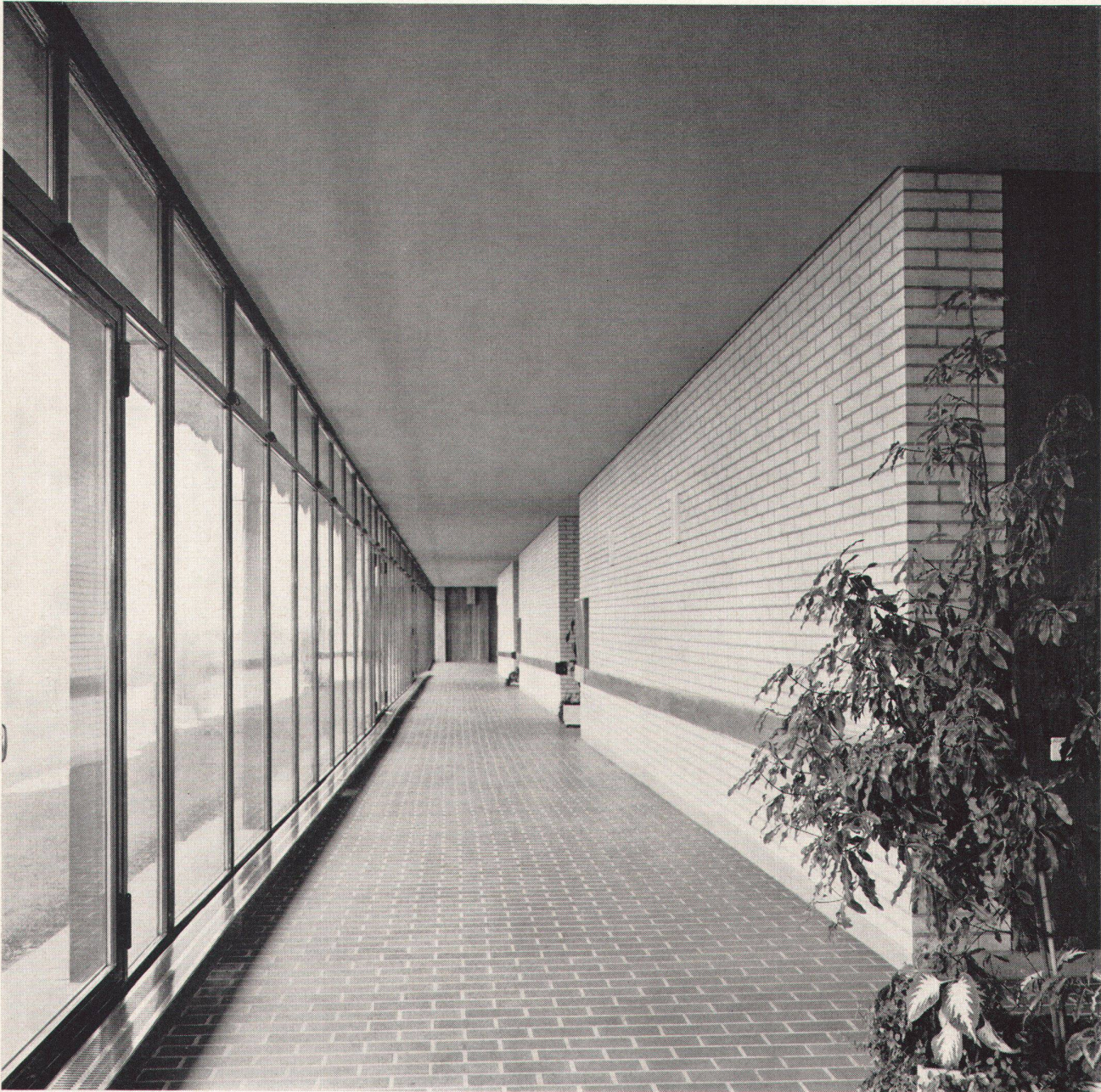
Glatte, heruntergehängte Decke aus Gitro-Platten
