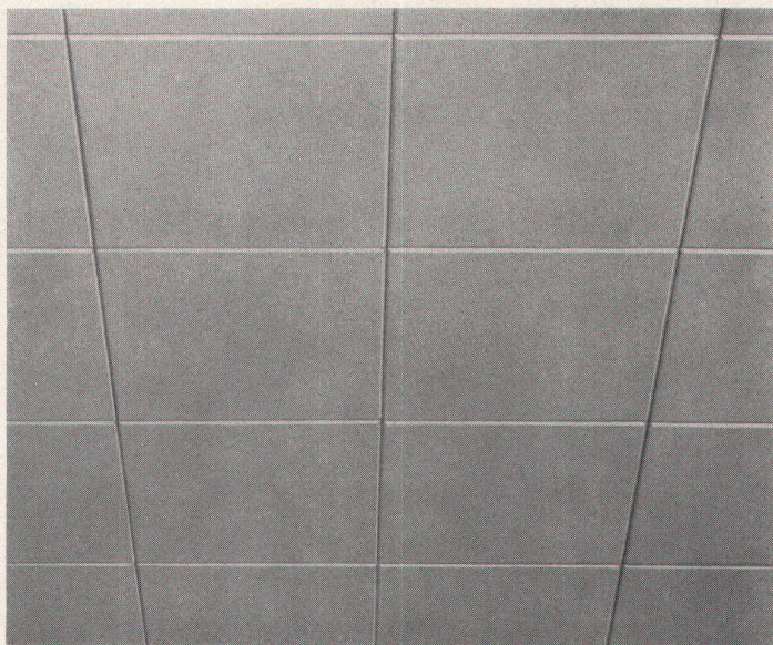
Turnhallendecke mit Durisol-Kassettenhourdis 90×90 cm, unten geschlossen, gefast, im Rahmen eines Schulhausneubaus in Grosswangen LU. Architekt: Thomas Jäger, Sandhügel, Beromünster Ingenieur: Ernst Wüest, dipl. Ing. ETH/SIA, Pilatusstrasse 55, Luzern
