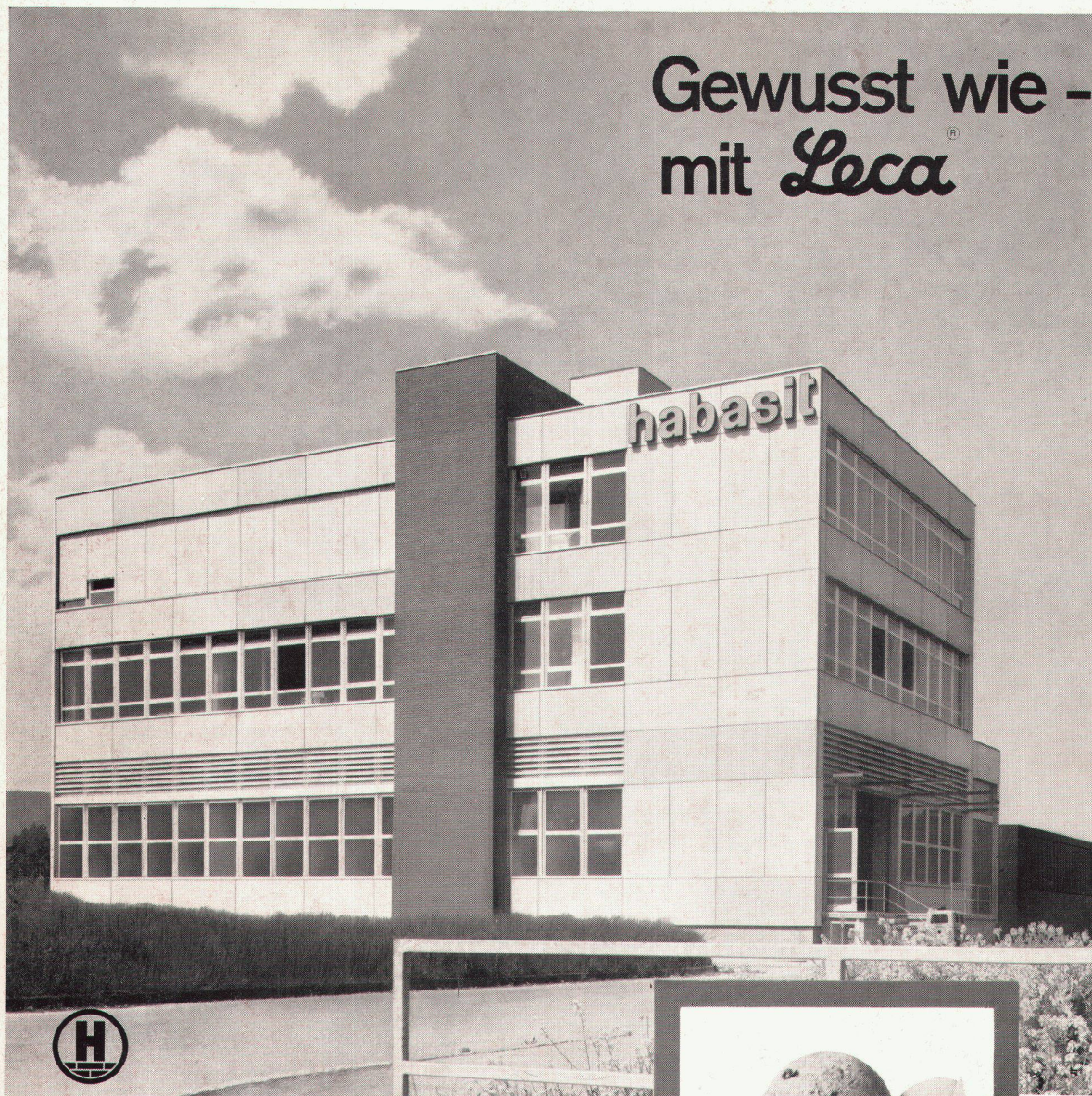
Vorfabrizierte Leca -Fassadenelemente an einem Fabrikgebäude der Habasit AG, Treibriemenfabrik, Reinach BL Architekten: M. + H. Burkhardt, BSA/SIA, Basel Statik: Gebrüder Gruner, Bauingenieure SIA, Basel Bauausführung: Max Pfaff, Bauunternehmung, Basel
