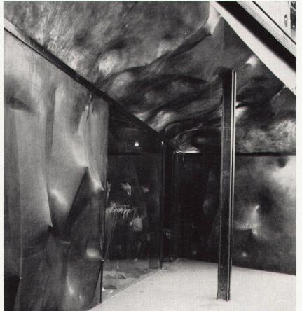
Piotr Kowalski, Mauer in Viry-le-Châtillon bei Paris, 1962. Beton, in situ mittels eines einzigen elastischen Models in Varianten gegossen Mur à Viry-le-Châtillon, près Paris. Béton, variantes de coulées produites in situ par le même moule élastique Wall in Viry-le-Châtillon, near Paris. Concrete, poured in situ, invariants,
