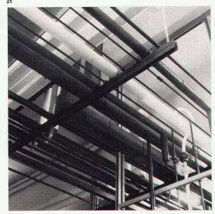
Die vorfabrizierten Luftkanäle aus Beton wurden mittels Schweißverbindungen am Bau befestigt
