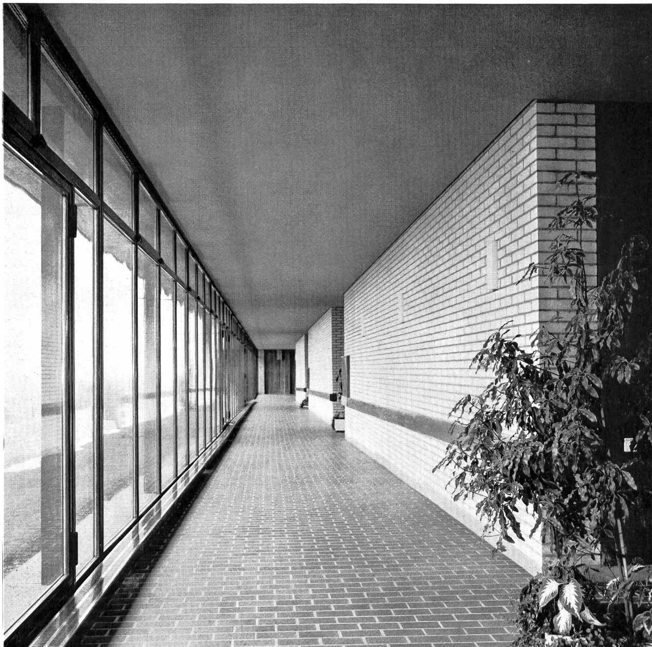
Glatte, heruntergehängte Decke aus Gitro-Platten
