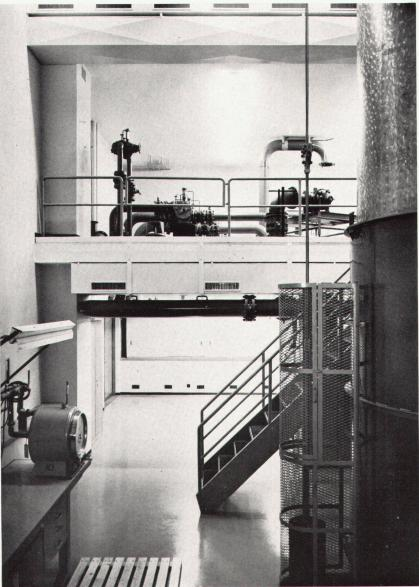
bunker ist ein Vander Graaff-Generator mit einer Leistung von 2 MeV untergebracht. Die hier durchgeführten Arbeiten umfassen die Technik der Messung von Strahlen der Härte von einigen Kiloelektronenvolt bis hinauf zu 2 MeV. Im gleichen Bereich liegen die Laboratorien für Arbeiten mit radioaktiven Standardpräparaten.
