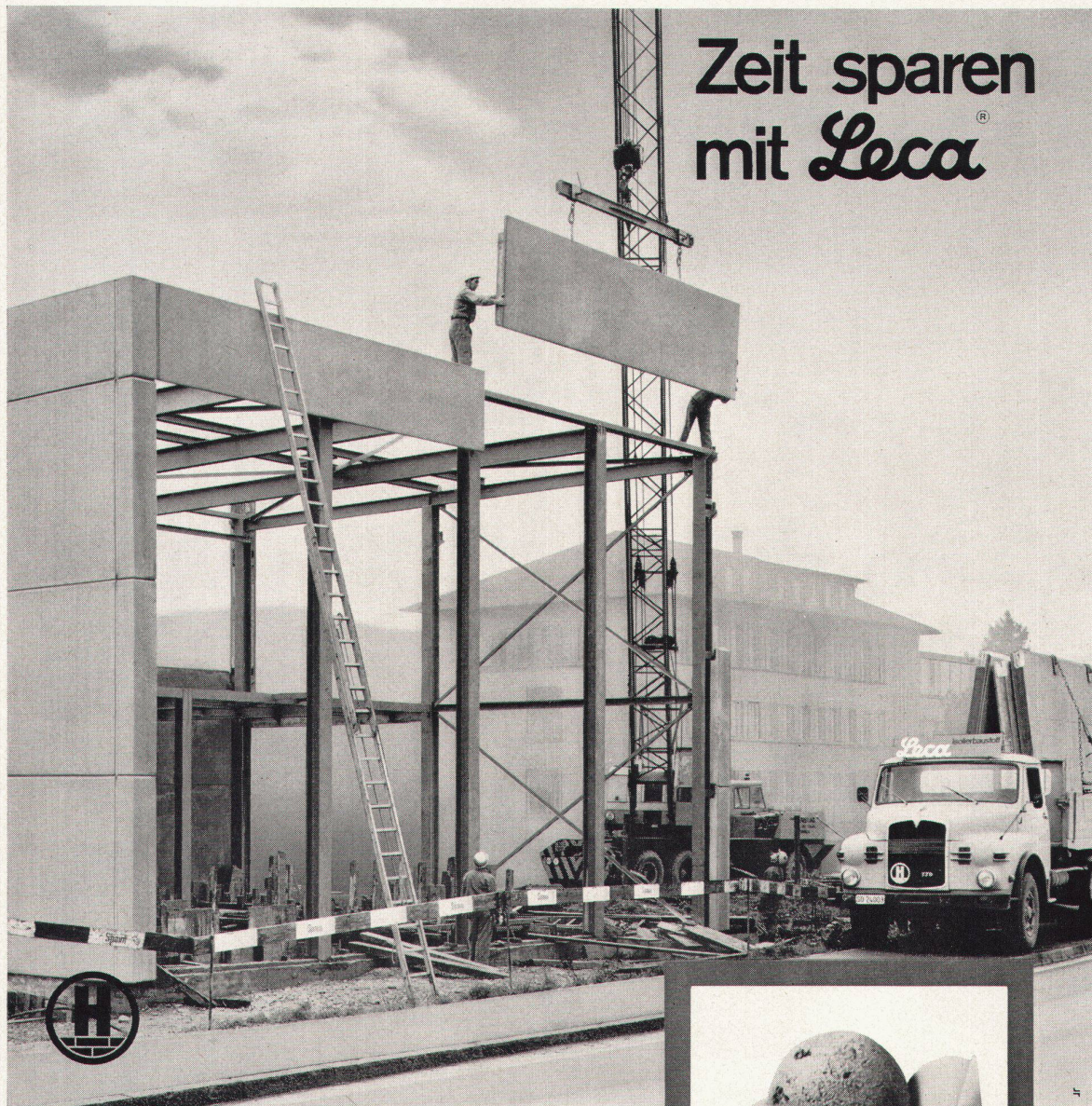
Montage von vorfabrizierten Leca -Fassadenelementen am Versuchslabor der Firma Buss AG in Pratteln Planung: Suter + Suter, Architekten BSA/SIA, Basel Stahlbau: Buss AG Pratteln
