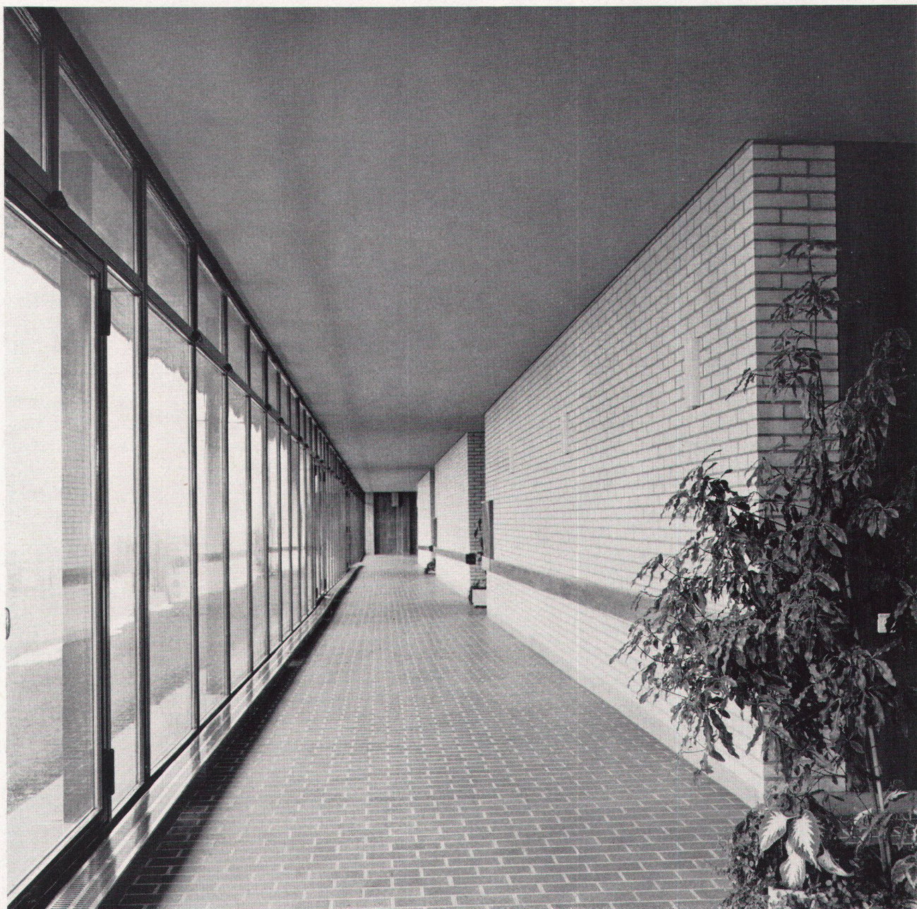
Glatte, heruntergehängte Decke aus Gitro-Platten
