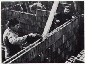
rettig armierte Deckenpartie vor dem Betonieren. Zwischenwandsteine werden nach dem Abschlagen zweier Lappen als Deckenhourdis
