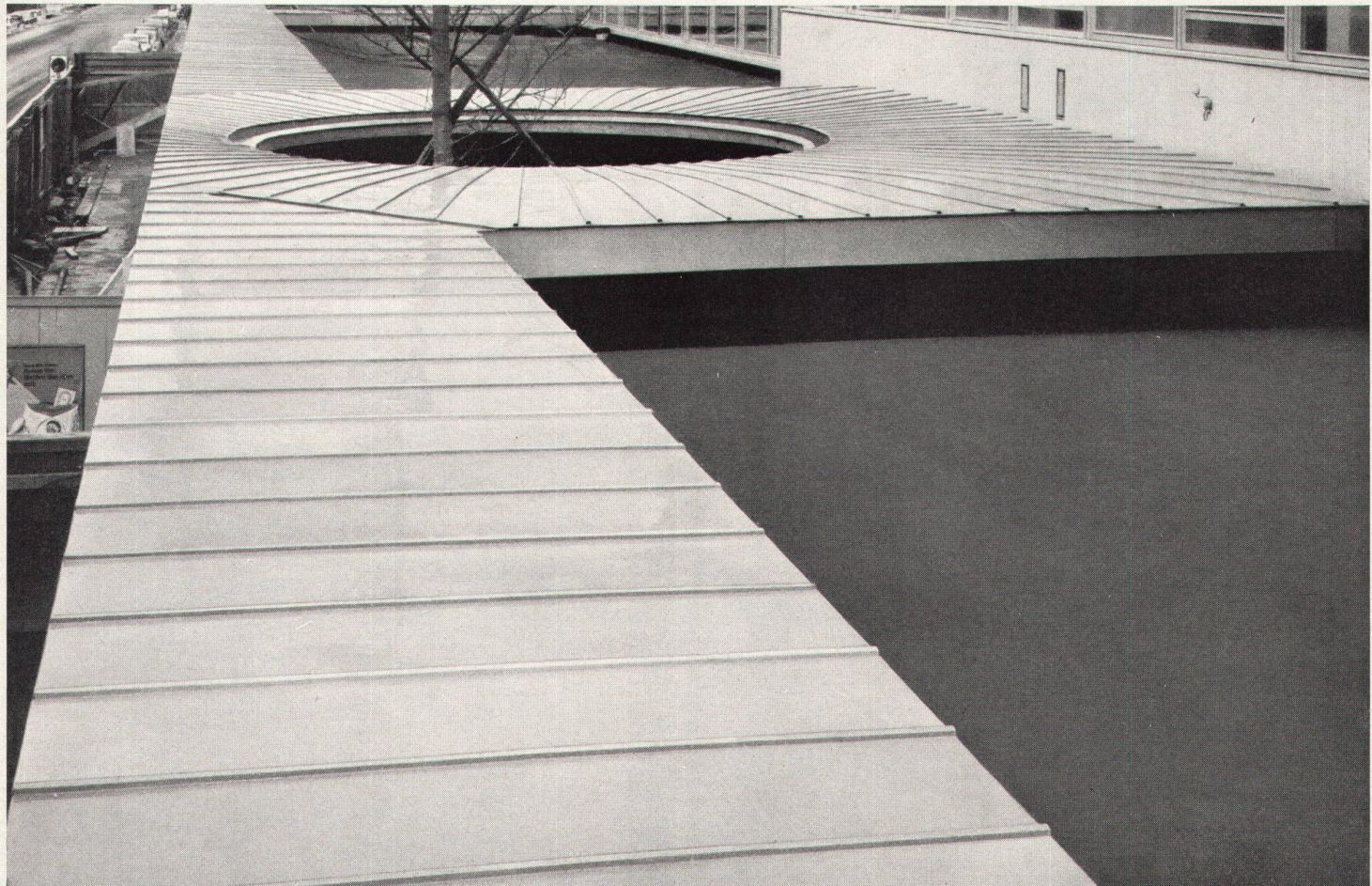
ALURIP kann mit metallisch blanker oder stahlgrauer Patina-Oberfläche, oder aber chemisch oxydiert geliefert werden.
