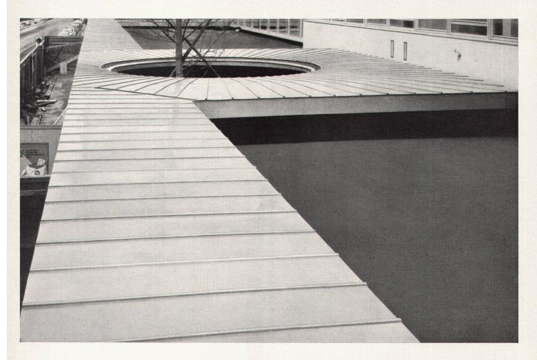
ALURIP kann mit metallisch blanker oder stahlgrauer Patina-Oberfläche, oder aber chemisch oxydiert geliefert werden. ALURIP wiegt nur 2,2 kg/m² und läßt sich normalerweise für Bedachungen bis zu 4% Neigung verwenden.
