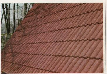
Rotbraun eingefärbte Dachsteine aus Beton
