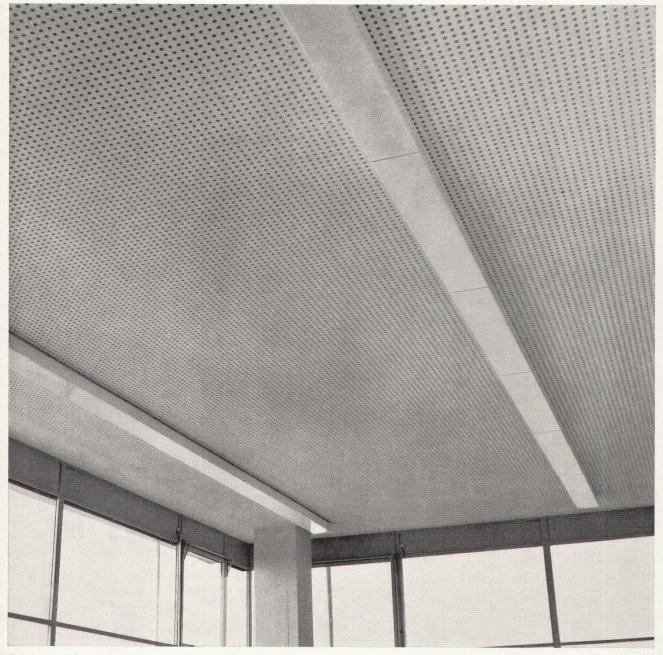
Fugenlose Schallschluckdecke aus Gitro-Platten
